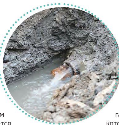
Труба деревянного водопровода
